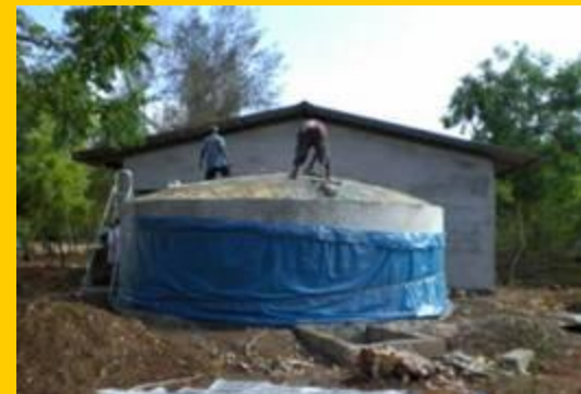
Fasi della costruzione della cisterna
