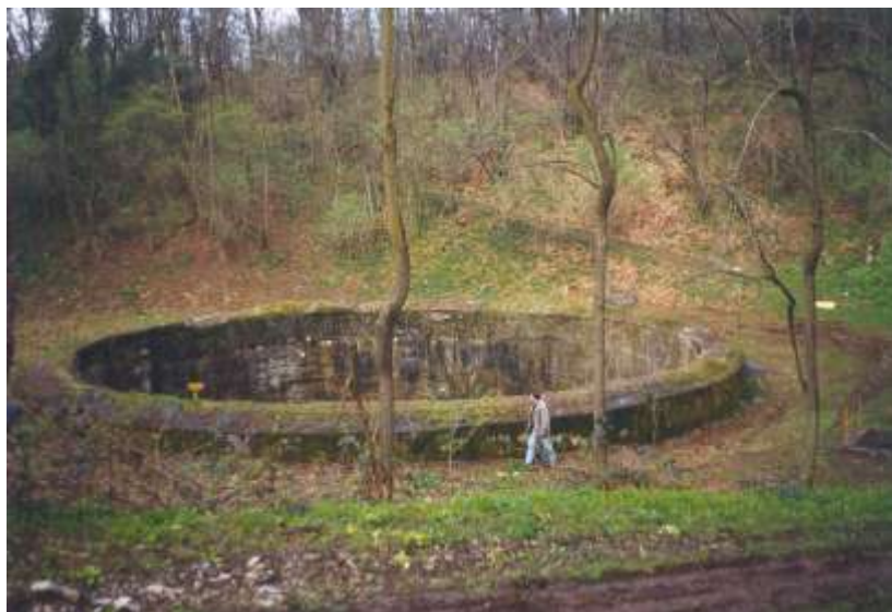
Serbatoio di carburante esploso
