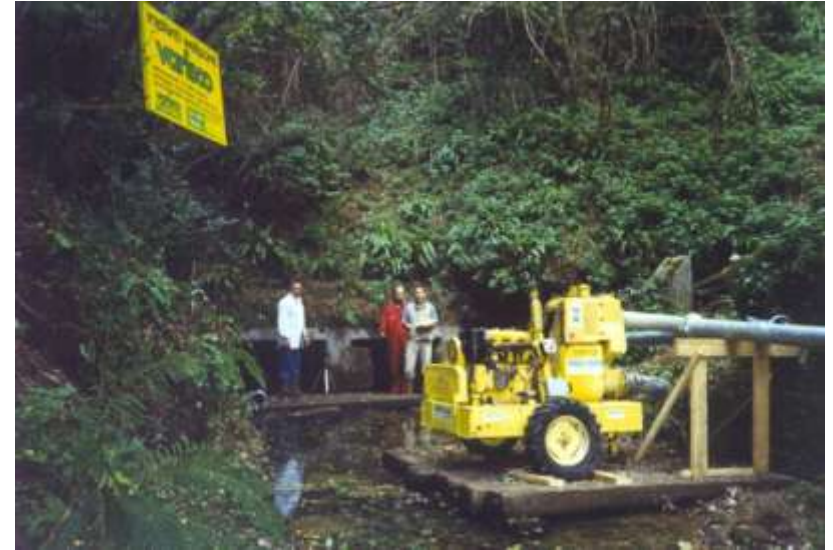
Ingresso della sorgente ad inizio lavori
