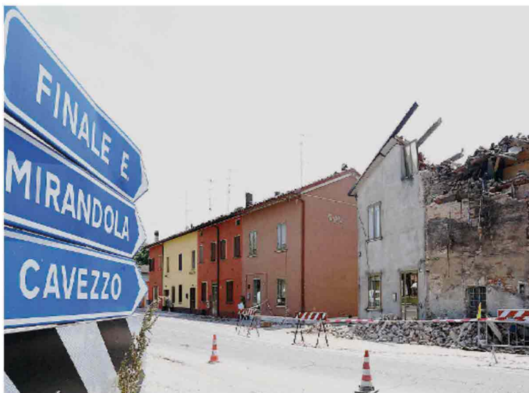
Le macerie dovute al sisma nei pressi di Rovereto sul Secchia in provincia di Modena
