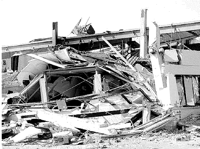
Uno dei capannoni industriali crollati a causa del terremoto in Emilia
