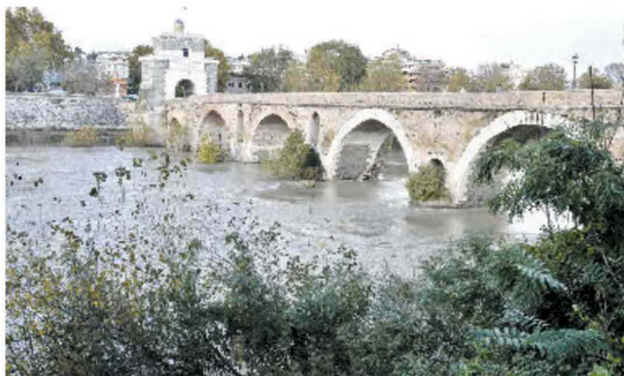
Tevere «Osservato speciale» all'altezza di Ponte Milvio
