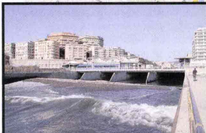
■ Dopo aver percorso il suo ultimo chilometro sotto i viali e i palazzi costruiti in epoca fascista, il Bisagno raggiunge il mare da uno sbocco in cemento armato.
