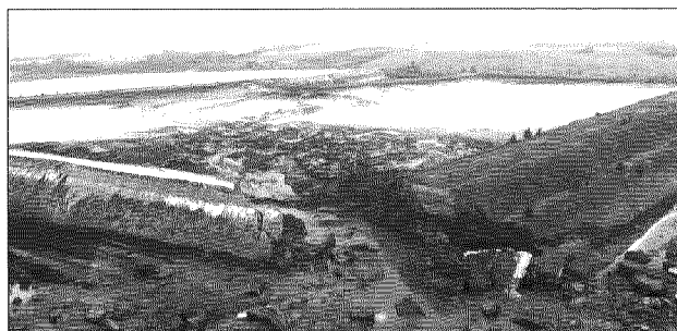
7. La rottura di un argine fluviale
