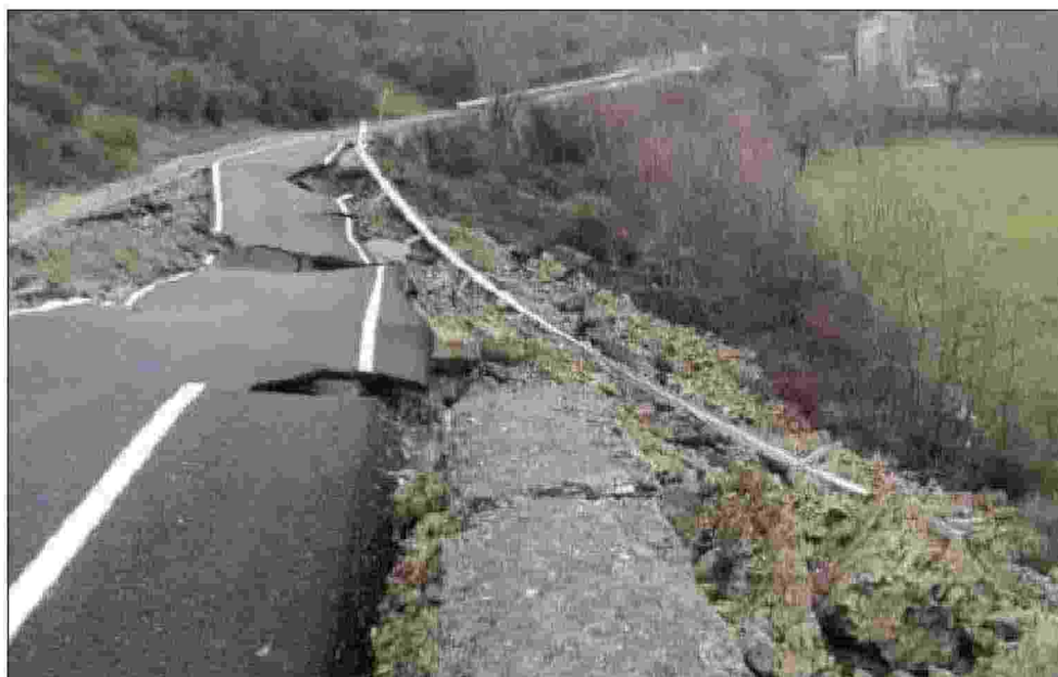
La frana su una strada calabrese
