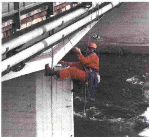
Intervento di manutenzione al ponte di Seriate
