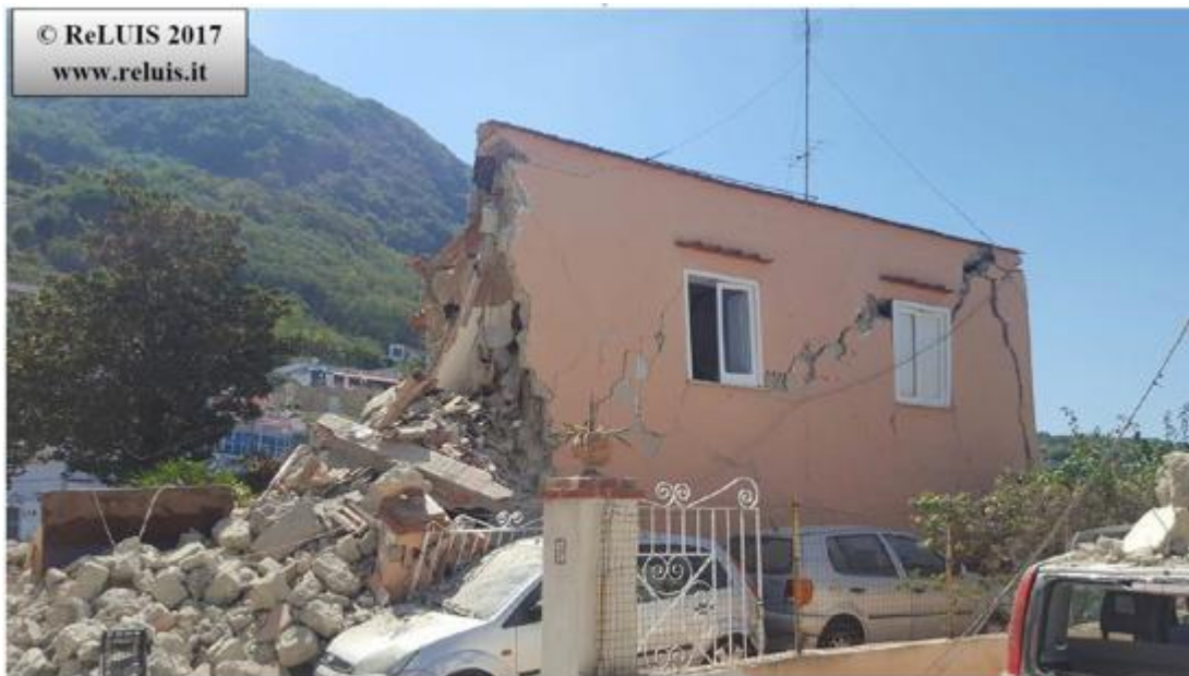
Edificio in Muratura - Via Montecito, Piazza Maio – Casamicciola Terme Crollo parziale dell'edificio: a) Google street view pre-evento; b) immagine post-evento sismico.
