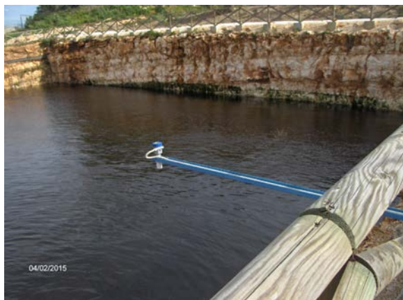
Foto 1 - Vasca in fase di carica, in primo piano il sistema di rilevazione del livello dell'acqua.
