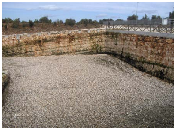
Figura 4 – realizzazione finale della vasca: sul fondo lo strato di breccia dello spessore di un metro che costituisce l'elemento di ulteriore filtro.
