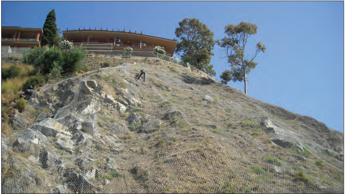
Figura 7 (in alto) – Fasi realizzative intervento. Figura 8 (in basso) – Sistemazione finale
