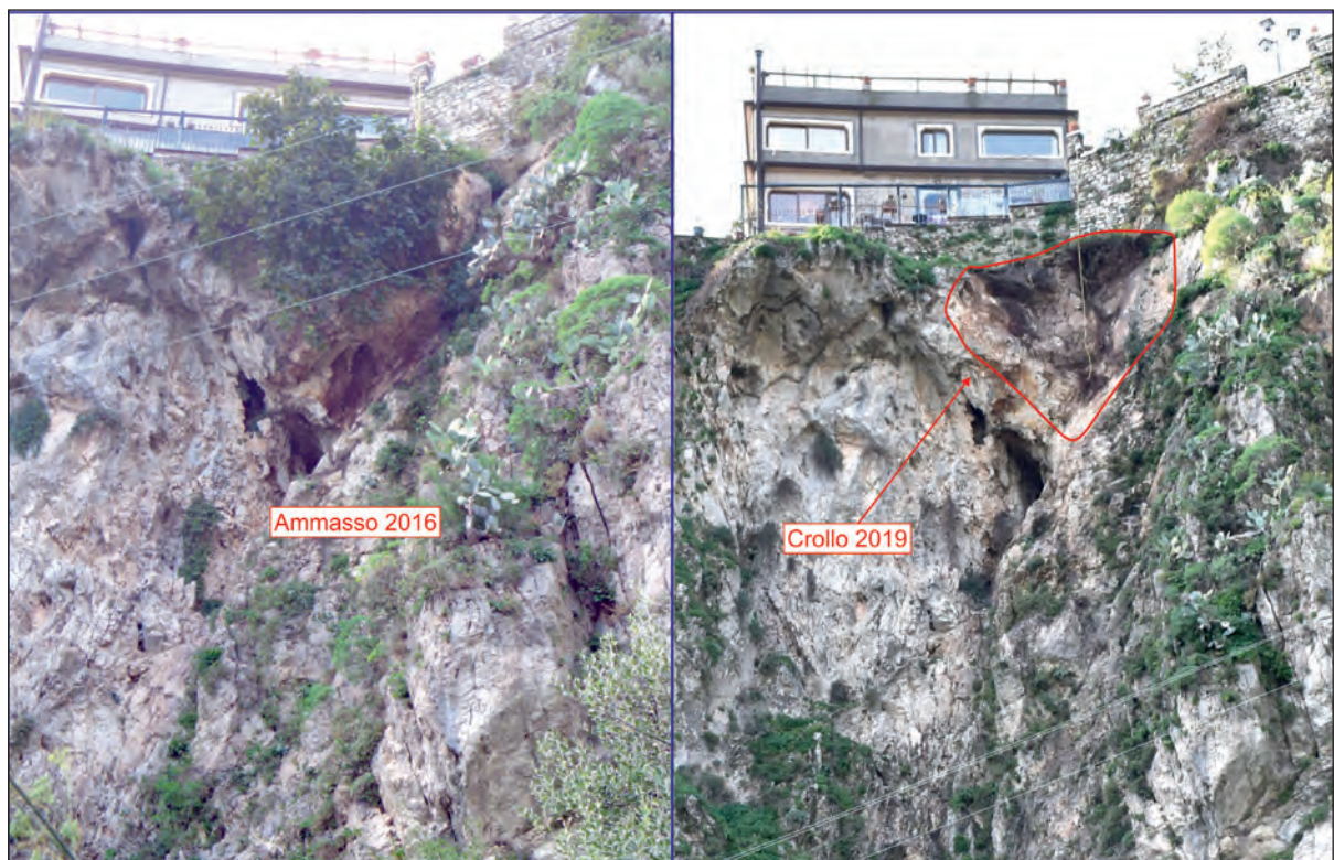
Fig. 1 - Raffronto fra le condizioni dell'ammasso nel 2016 a sinistra e nel 2019 a destra (si noti l'assenza del grosso cuneo roccioso ancora presente nel 2016)
