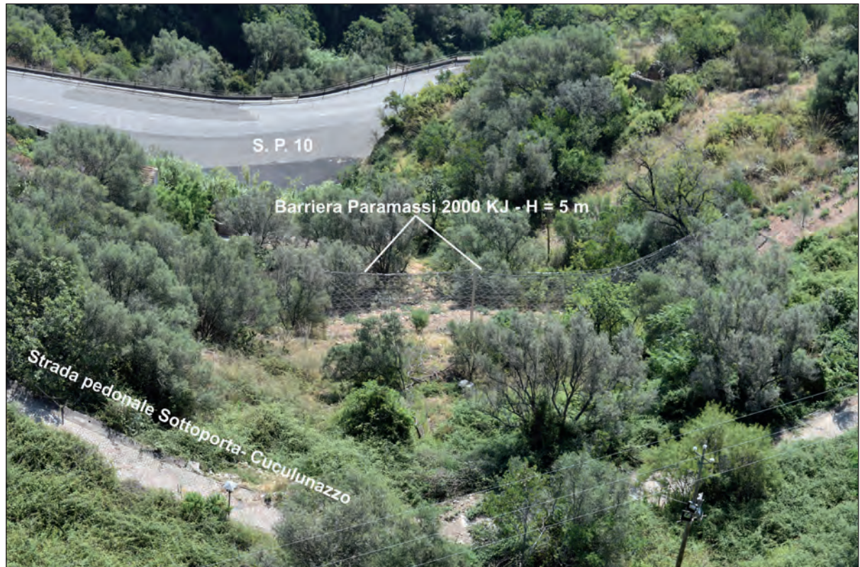
Fig. 13 – Barriera paramassi realizzata
