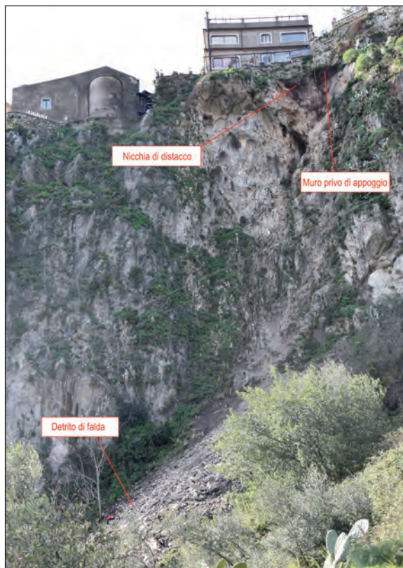
Fig. 3 - Nicchia di distacco e detrito di falda alla base della parete
