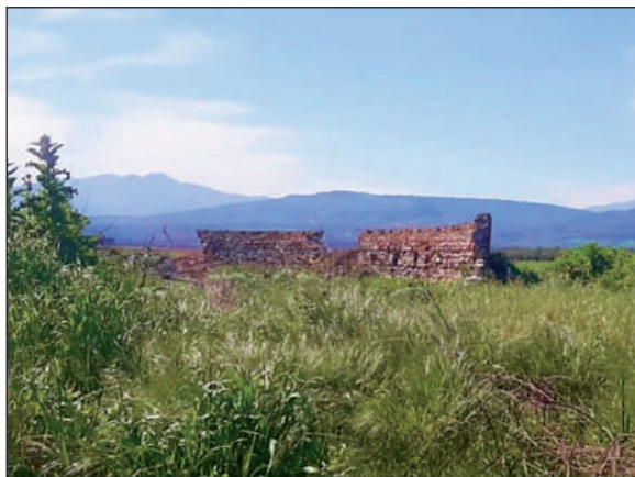
Figura 25 – Tratto di muro affiorante lungo l'allineamento planimetrico ad emiciclo.
