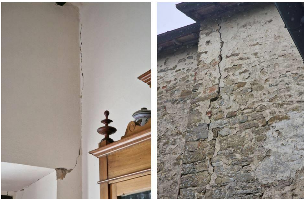
Figura 4 – Meccanismi di ribaltamento delle pareti (Credit: Marco Peroni)
