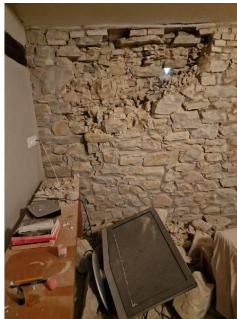
Figura 1 – Due casi di espulsione del paramento esterno/interno di una parete a sacco in sasso (Credit: Marco Peroni)
