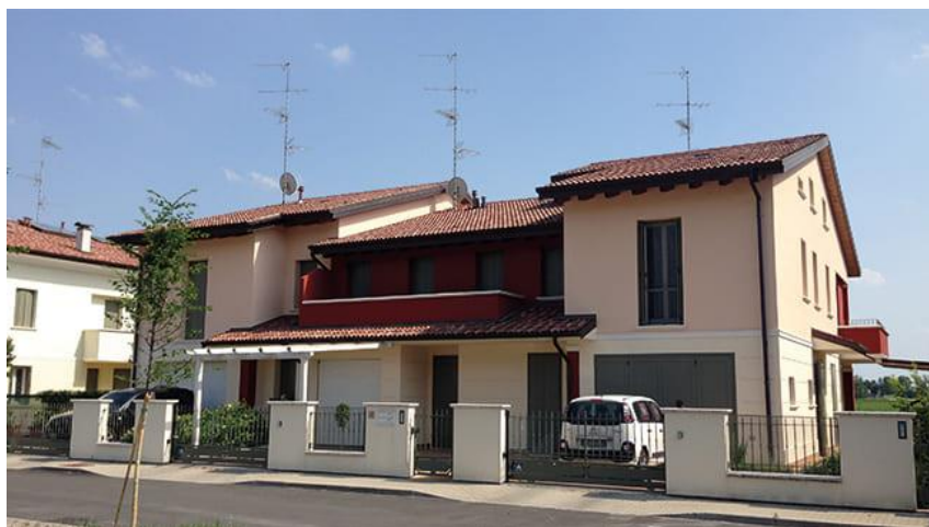
Fig. 5 – La progettazione di un edificio residenziale in muratura armata a Mirandola (MO), che ha superato indenne il terremoto del 2012. Volponi N. e Pellicciari A., pubblicato su Murature Oggi n.126.
