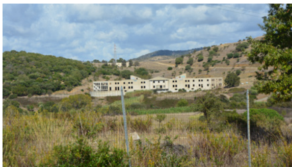
Figura 9 – L’edificio della struttura termale di Civitavecchia non completato e abbandonato.
