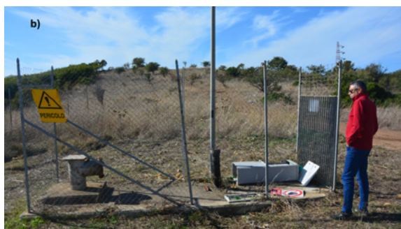
Figura 8 – a. Il pozzo n. 5 completo di tutte le strutture idrauliche. b. Il pozzo n. 2 privo di tutte le strutture idrauliche.
