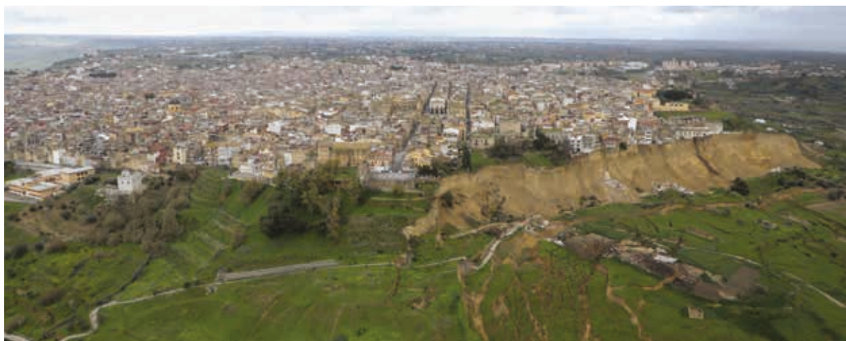
Frana di Niscemi 2026" di Dipartimento della Protezione Civile | "Niscemi landslide 2026" photo by the Civil Protection Department
