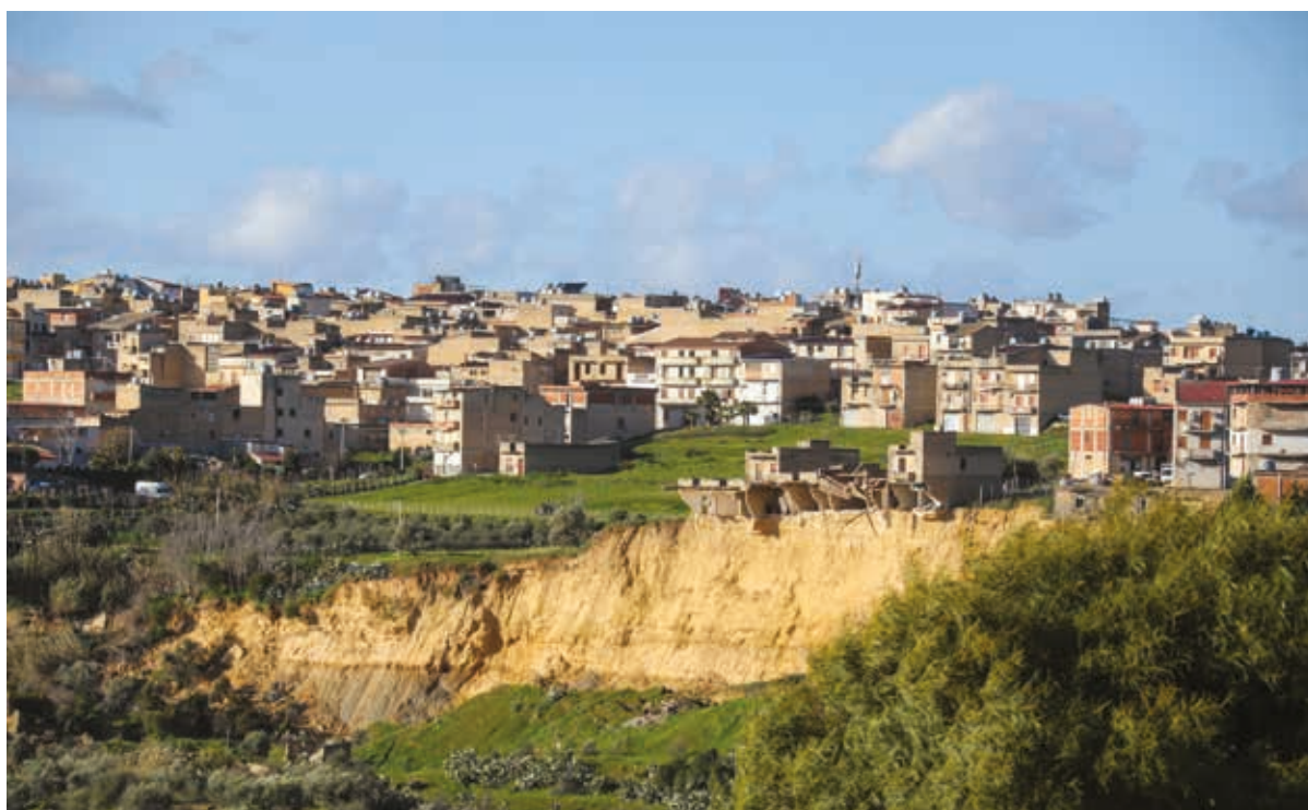
“Frana di Niscemi 2026” di Dipartimento della Protezione Civile | “Niscemi landslide 2026” photo by the Civil Protection Department
