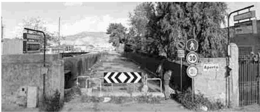
LA COPERTURA DEL CANALE PASSO DI RIGANO
