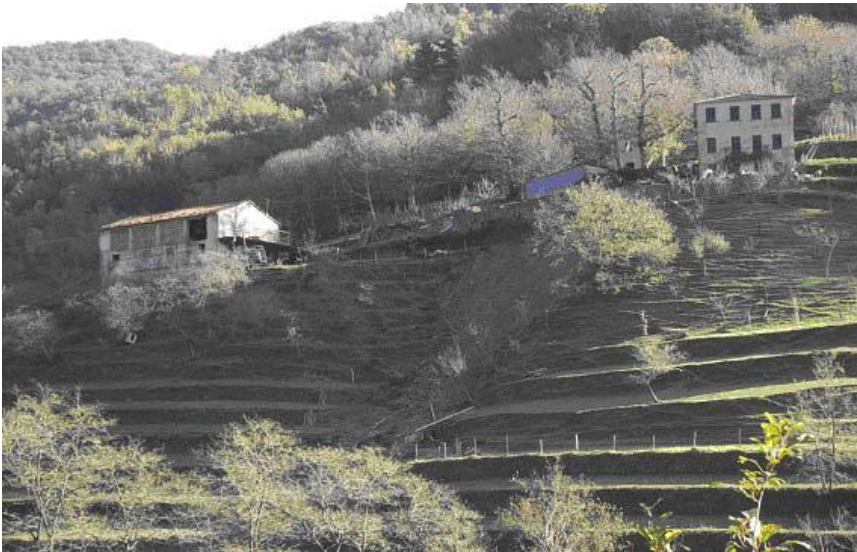
Vista frontale del movimento franoso a valle del sentiero comunale in località Licciorno (GE)
