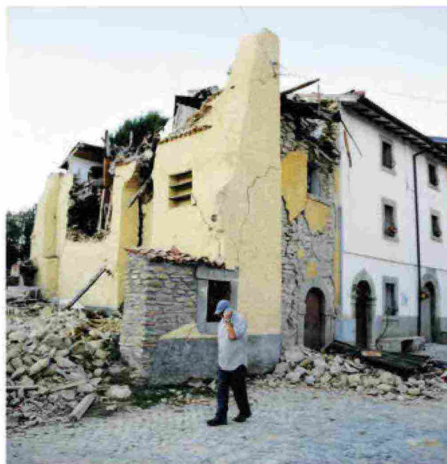
GLI EDIFICI SBRICIOLATI - Uno dei tanti edifici sbriciolatisi per effetto del sisma. Se fossero stati messi in sicurezza sarebbero rimasti in piedi senza problemi, spiega Peduto.
