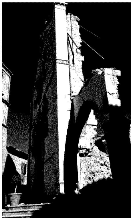
Quel che resta della basilica di San Benedetto a Norcia dopo il sisma
