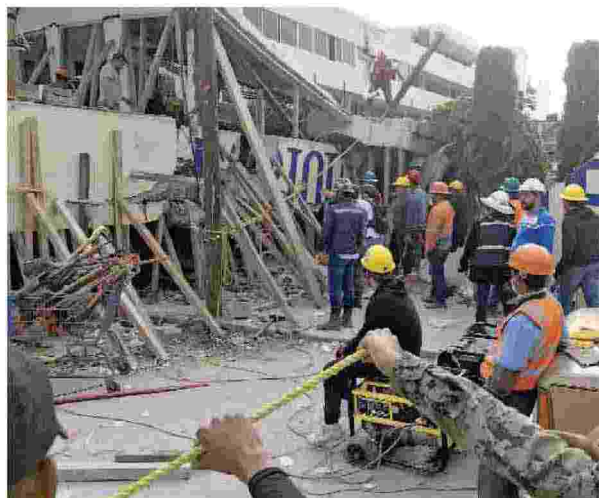
Gli edifici sono puntellati con travi di legno per non rischiare altri crolli
