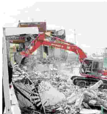
La demolizione di un edificio
