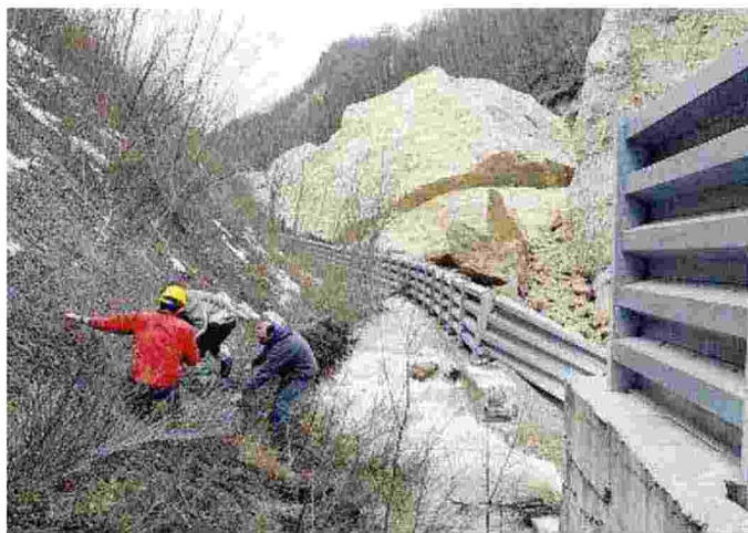
Geologi al lavoro per valutare il movimento di una frana
