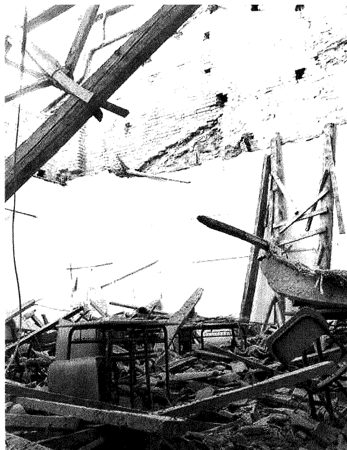
Macerie Le conseguenze del crollo del tetto di un'aula dell'istituto tecnico «Montani» di Fermo (foto Ansa)
